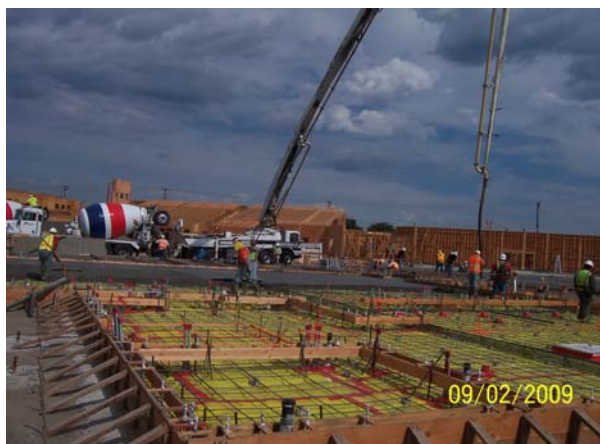
Building B & C - Slab on Grade Concrete Pour
