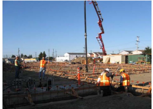
Concrete Pour Stem Walls at North End
