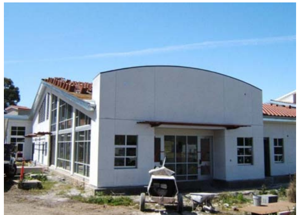
Building A: Ext. Stucco, Storefront & Windows
