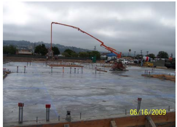
Footing pour at A East
