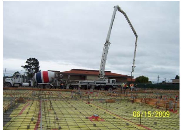
Slab on grade concrete pour at A west
